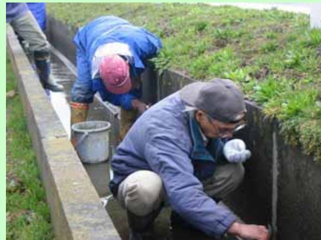
水路の補修やゲートの塗装
