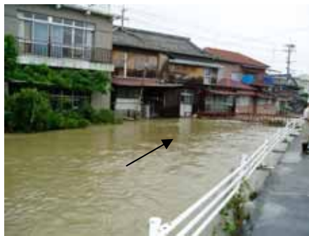
土穂石川の浸水状況 (柳井市新庄地区)
