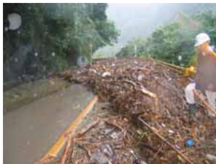
錦川沿いの国道187号 (岩国市美川町四馬神地区)
