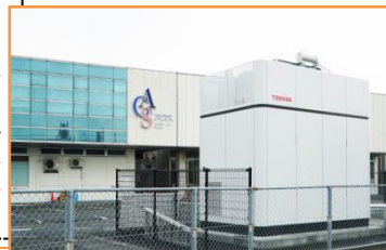
←株式会社トクヤマが導入した100kW純水素型燃料電池 (環境省「地域連携・低炭素水素技術実証事業」)
