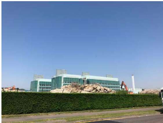
写真 2. PHE の移転先の現在のキャンパスに存在する旧 GSK キャンパス内に存在する旧 GSK 研究施設を敷地外の南側から撮影した。現在、不要な建物を取り除く作業がなされていた。
