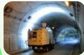
高性能カメラ搭載車によるトンネルの点検
