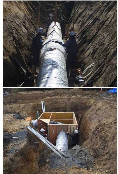
配水管の布設状況 (開削工法)
