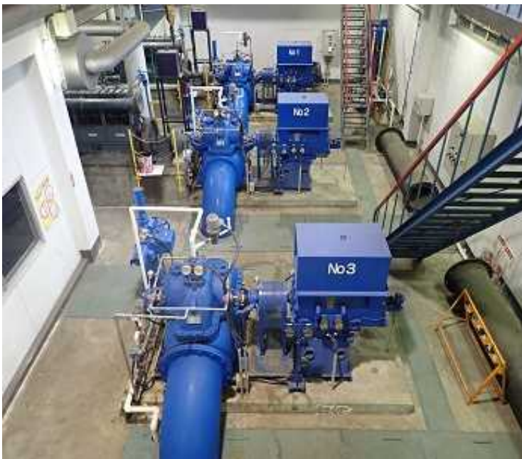
送水ポンプと機械設備等の現況 [小瀬川工業用水道]
