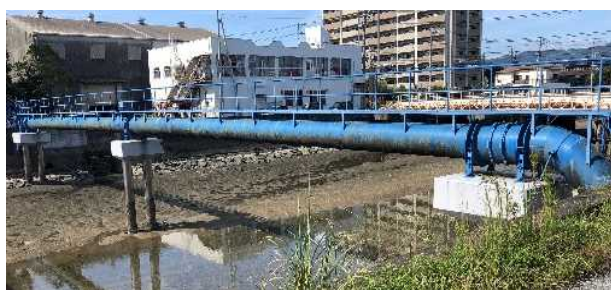
平田川水管橋の現況 [周南工業用水道]
