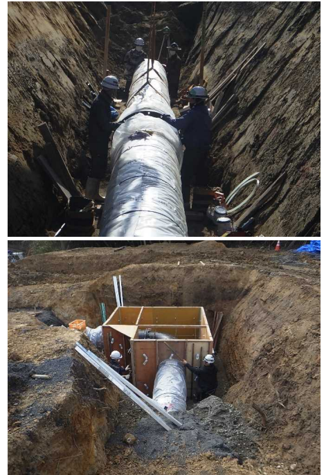
配水管の布設状況 (開削工法)
