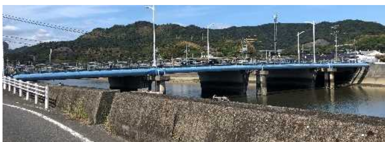
夜市川水管橋の現況 [富田・夜市川工業用水道]
