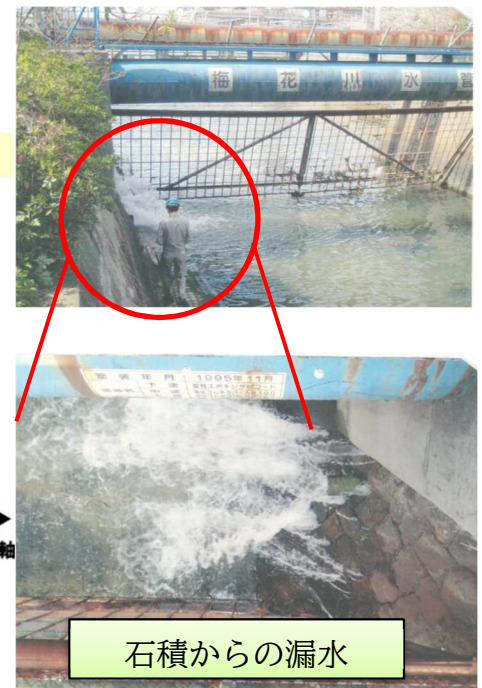
【工業用水道施設の漏水事故の例】
