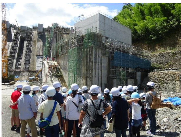
《建設中の平瀬発電所》
