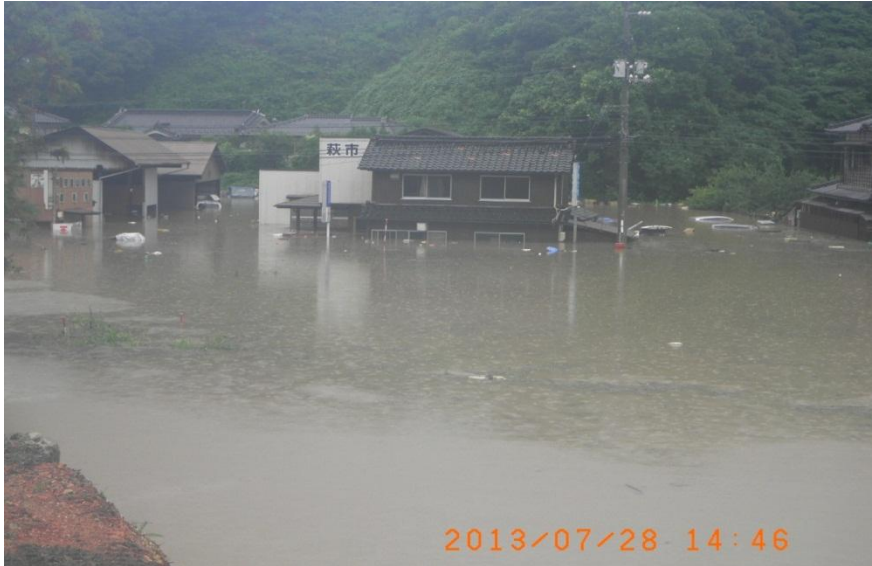
萩市下田万 二級河川田万川 浸水状況
