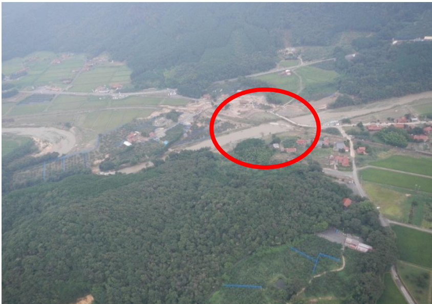
阿武川第6橋梁流失
