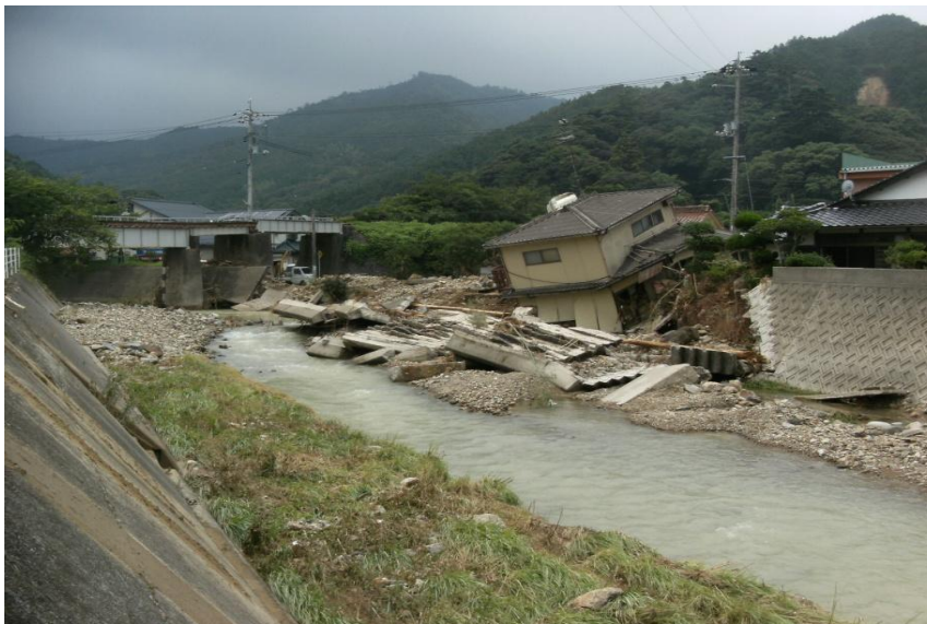
萩市須佐 二級河川須佐川 護岸崩壊 家屋倒壊
