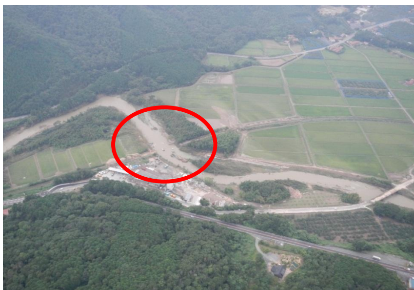
阿武川第5橋梁流失
