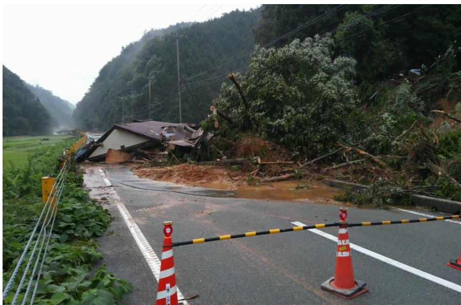
山口市阿東嘉年下 一般国道315号 法面崩壊
