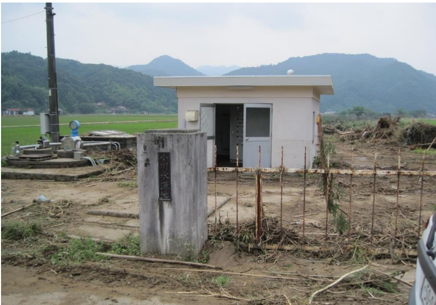
萩市小川浄水場
