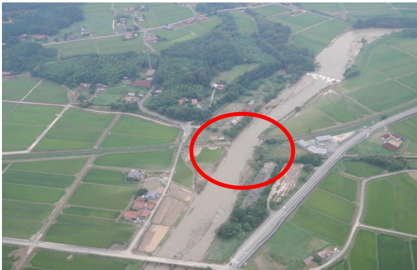
阿武川第4橋梁流失
