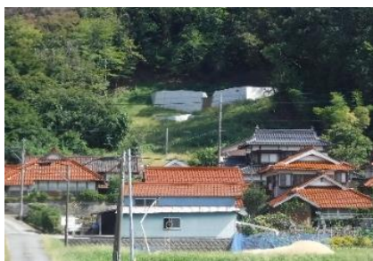
治山ダムの整備
