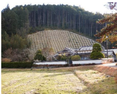
山腹工による山地災害の復旧
