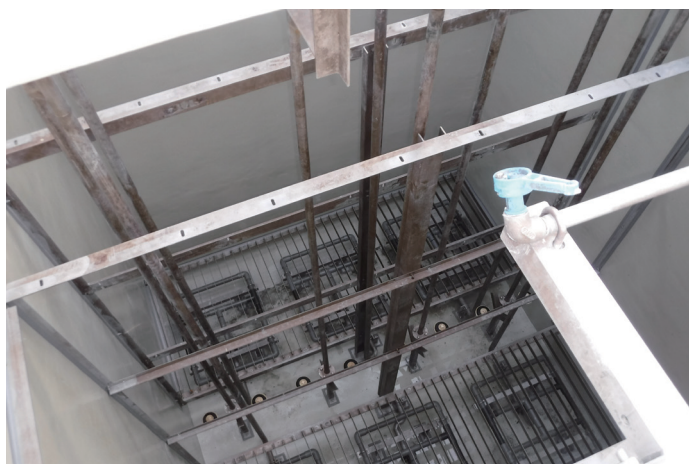
集落排水施設の処理槽防食(柳井市:余田北)
