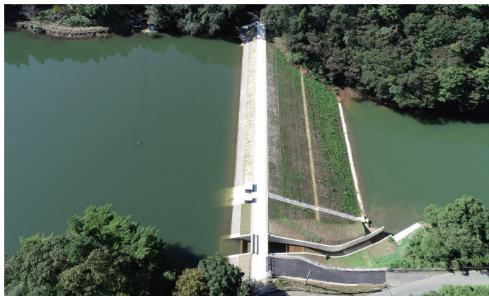
ため池の改修(防府市:上洗川)
