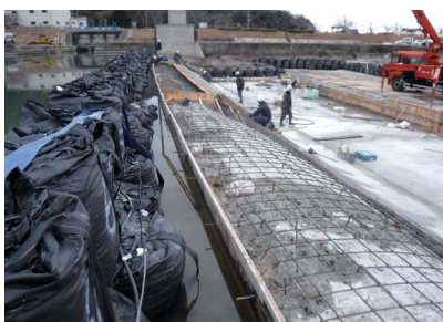
頭首工の修繕(防府市:防府総合堰)
