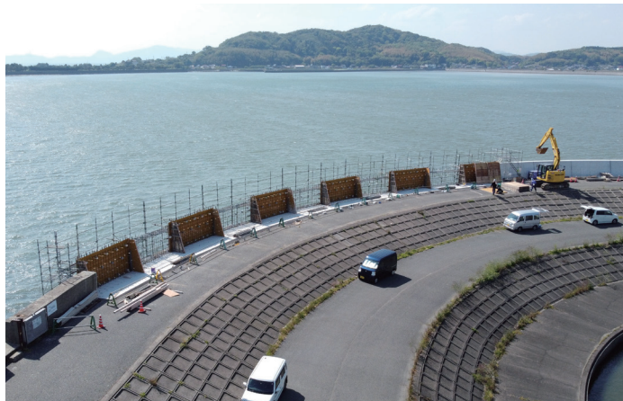
海岸堤防の補強(山陽小野田市:黒崎開作)
