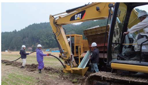
フォアス施工(萩市:堀越)
