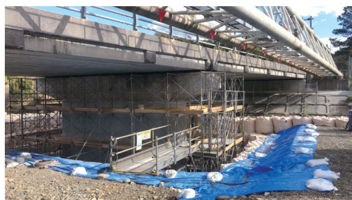
橋の耐震補強(長門市:長門大津)
