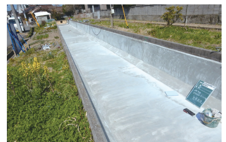
水路の補修(宇部市:御撫育)
