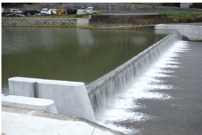
頭首工の改修(山口市:井手口)
