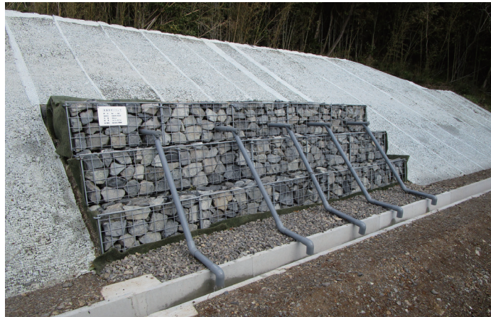
水抜きボーリング(長門市:油谷島)
