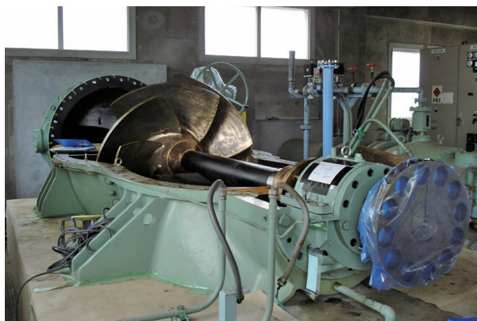
排水ポンプの分解整備(下関市:百間)
