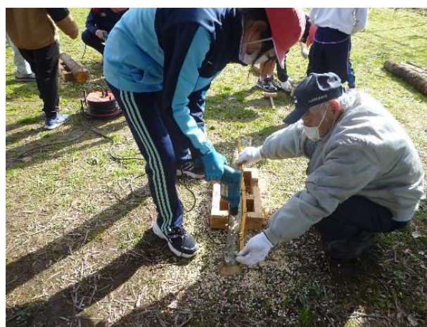
電気ドリルを使った穴あけ作業
