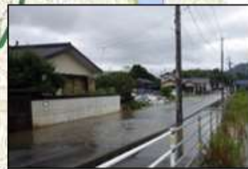
平成30年7月豪雨 浸水状況
