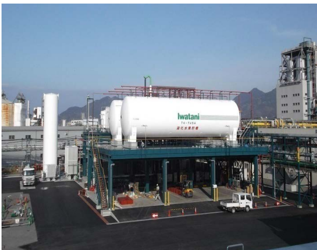
〔液化水素製造工場（周南市）〕
