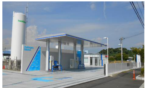
「水素ステーション」
