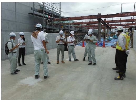
館林土木事務所 職員現場研修会（打設状況）
