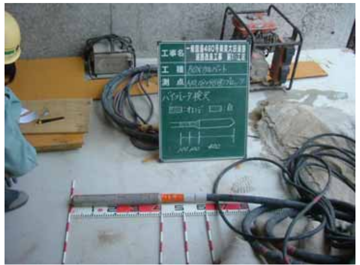
バイブレータのチェック・検尺
