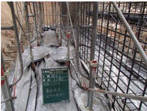
湿潤保温養生
