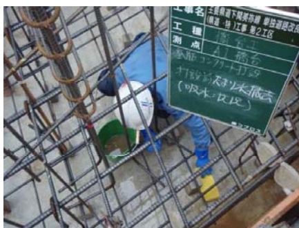
型枠内部溜り水除去
