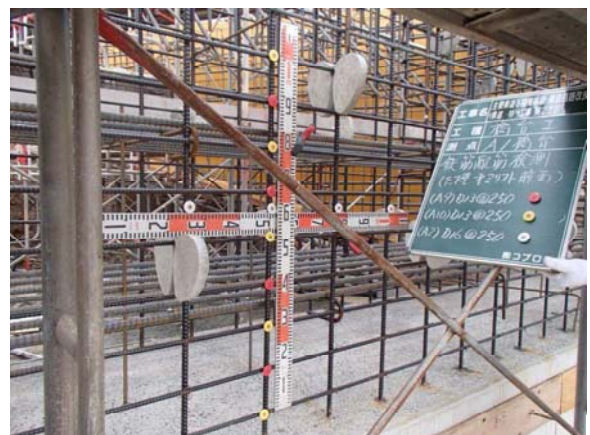
補強鉄筋B（表面付近への補強鉄筋）
