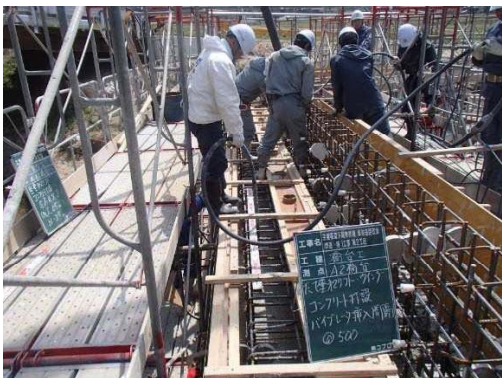
打ち込み面までの高さ確認
