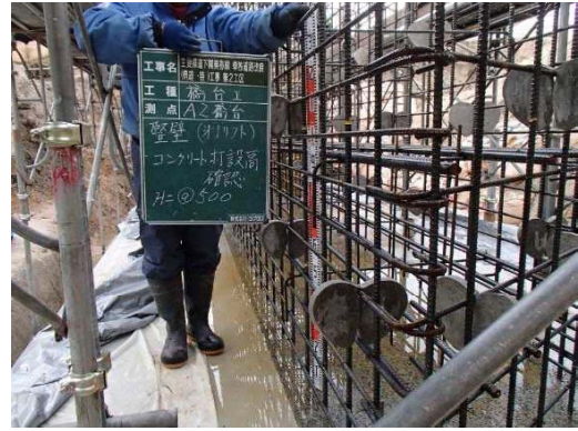
コンクリート打設高さ (鉄筋マーキング)
