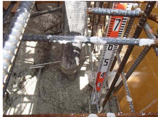
打ち込み面までの高さ 1.5m以下
