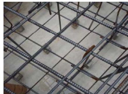
型枠面、打継面の散水
