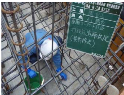
型枠内部の異物除去
