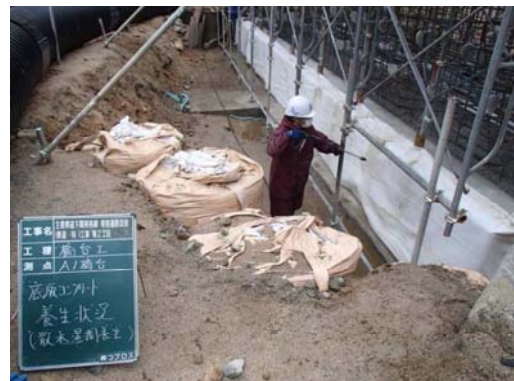
脱枠後散水養生
