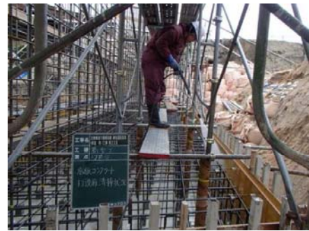
高圧洗浄機による型枠内清掃
