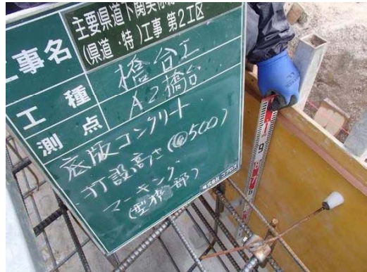
コンクリート打設高さ (型枠マーキング)
