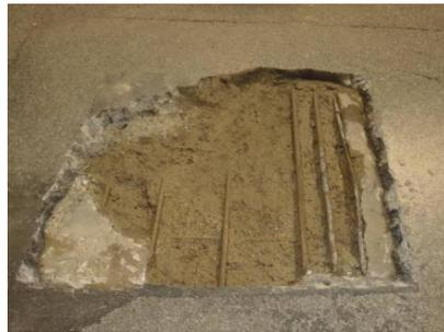
RC床版の土砂化（ASR, 凍害, 疲労の複合劣化）
