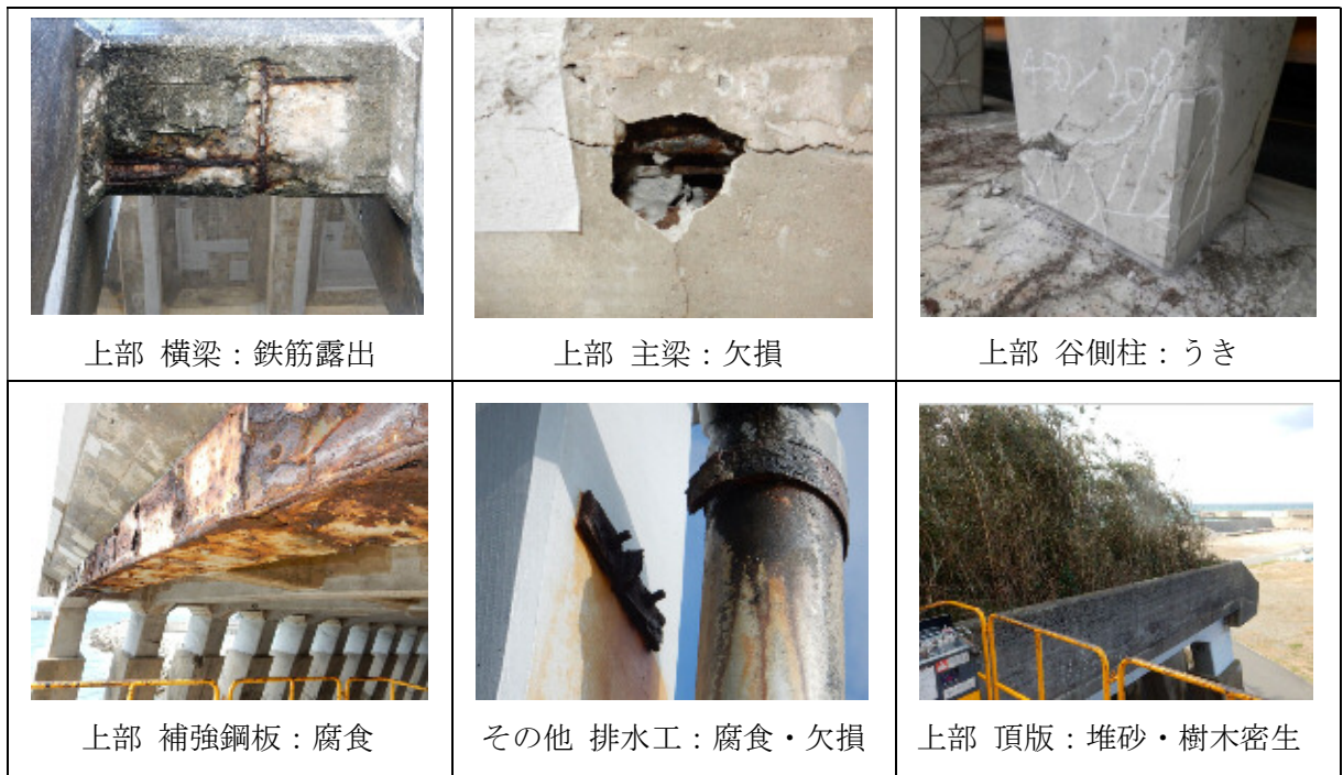
<主な損傷状況（コンクリート製シェッド）>
