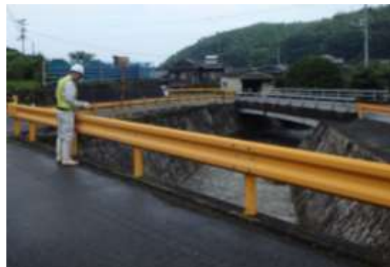
＜河川巡視状況＞
