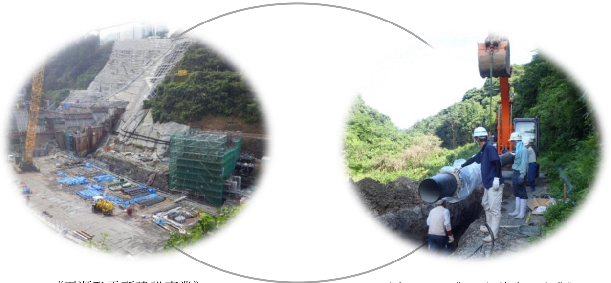
《平瀬発電所建設事業》
