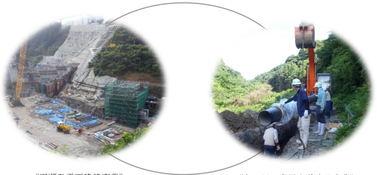
《平瀬発電所建設事業》
