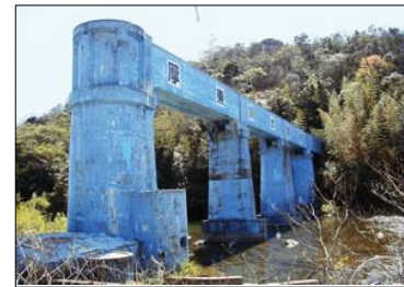
《厚東川水路橋》
