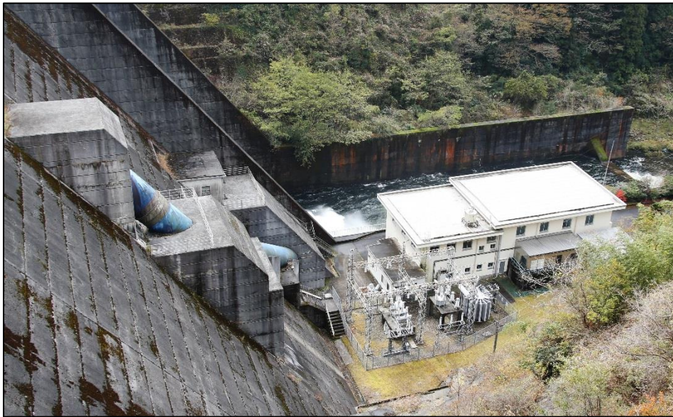
平成 29 年度「水力発電所フォトコンテスト」 最優秀賞『菅野ダム・発電所』 (撮影：田村武彦さん)
