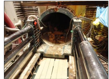
《工事中の厚東川横断管》
