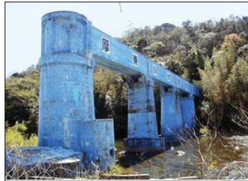
《厚東川水路橋》
