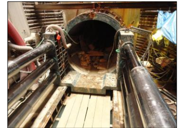
《工事中の厚東川横断管》
