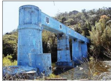
《厚東川水路橋》
