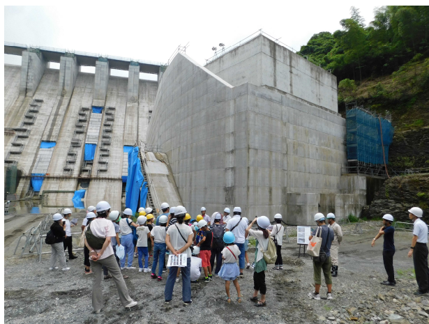
《建設中の平瀬発電所》
