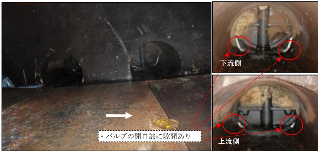
写真-2.26 ④排水バルブ断面
