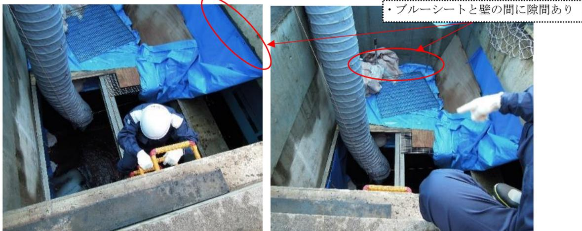
写真-2.29 ③立坑上部断面目張り状況
