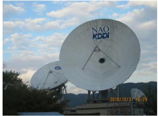
敷地には、国際通信用の衛星との交信用のパラボラアンテナが多数並んでいる。最大のものは直径34mで、これは衛星通信用パラボラアンテナとしては日本一の大きさである。パラボラアンテナの「パラボラ」とは放物線のことであり、アンテナの断面のカーブは、放物線の形になっている。
