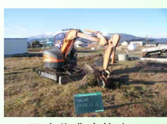
再生作業実施中
