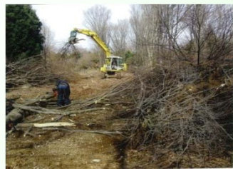
再生作業実施中
