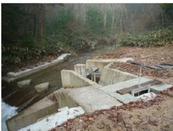
< 福谷ため池取水口 >
