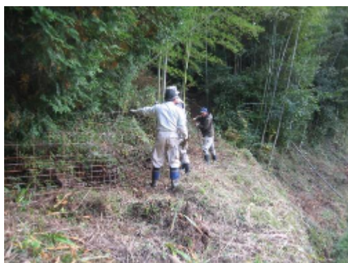
【共同作業での防護柵の設置】
