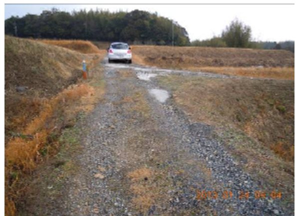
【 舗装工事予定の農道】
