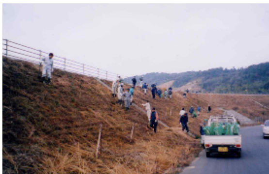
(法面の整備の様子)
