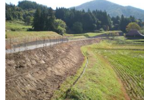
水路周辺の整備
