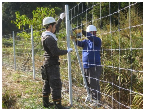
【鹿用防護柵設置】
