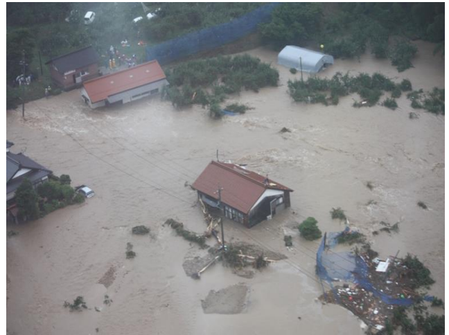
平成 25 年 7 月 28 日大雨災害被害
