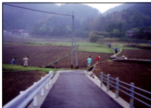
水路の清掃作業
