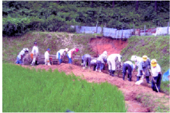
【法面・水路補修作業】
