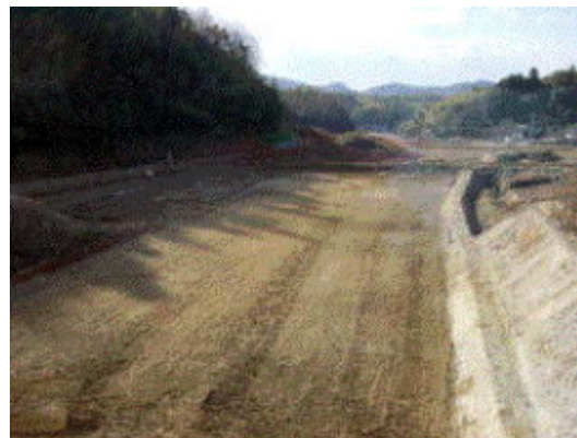
基盤整備中のほ場
