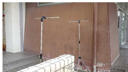
生徒玄関に設置された大型ミスト装置
