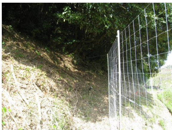
実践活動により設置した侵入防止柵（境川地区）
