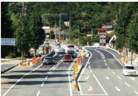
仮復旧された国道262号上勝坂橋
