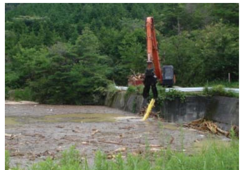
玉泉ため池における流木撤去作業
