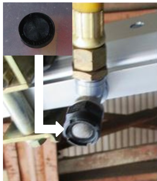
図2 通常ノズルの封鎖 専用の栓（市販品）を用いて封鎖
