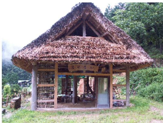
(建設中の交流施設)
