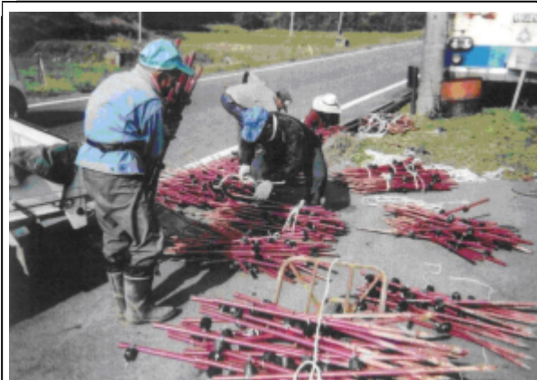
電気柵撤去作業 2
