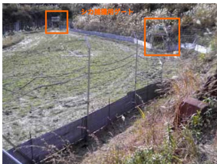
写真 1-1 シカ被害防護柵兼捕獲柵（捕獲柵状態）
