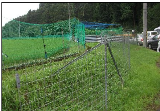
《設置された防護柵》
