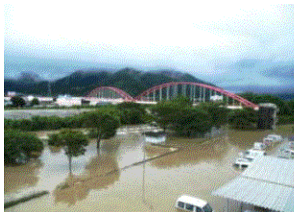
平成21年7月豪雨による洪水被害（山口市）
