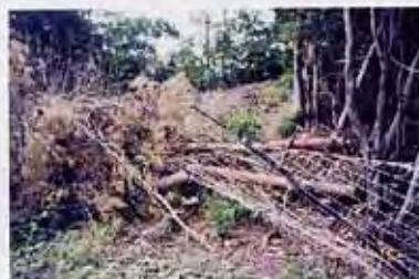
倒木に巻き込まれた柵 これではせっかくの柵が台無し!
